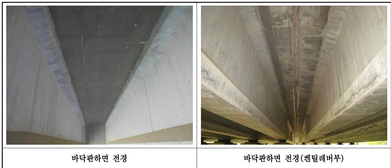
【사진 1.3.2】 바닥판하면 전경
