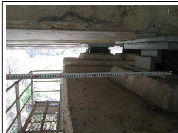
받침장치 연단거리 측정
