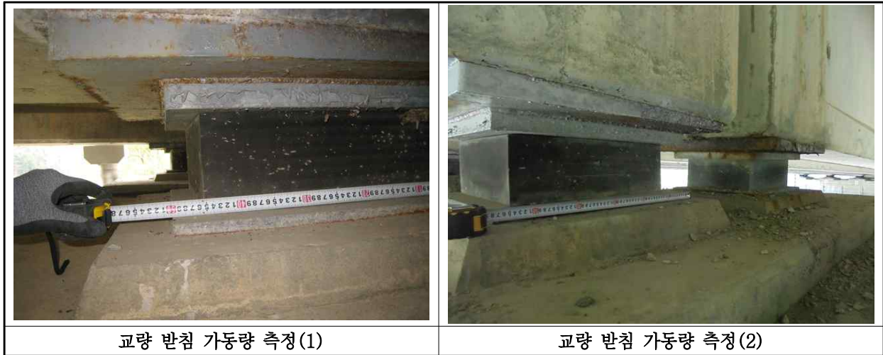
【사진 1.3.15】 교량받침 이동량 측정
