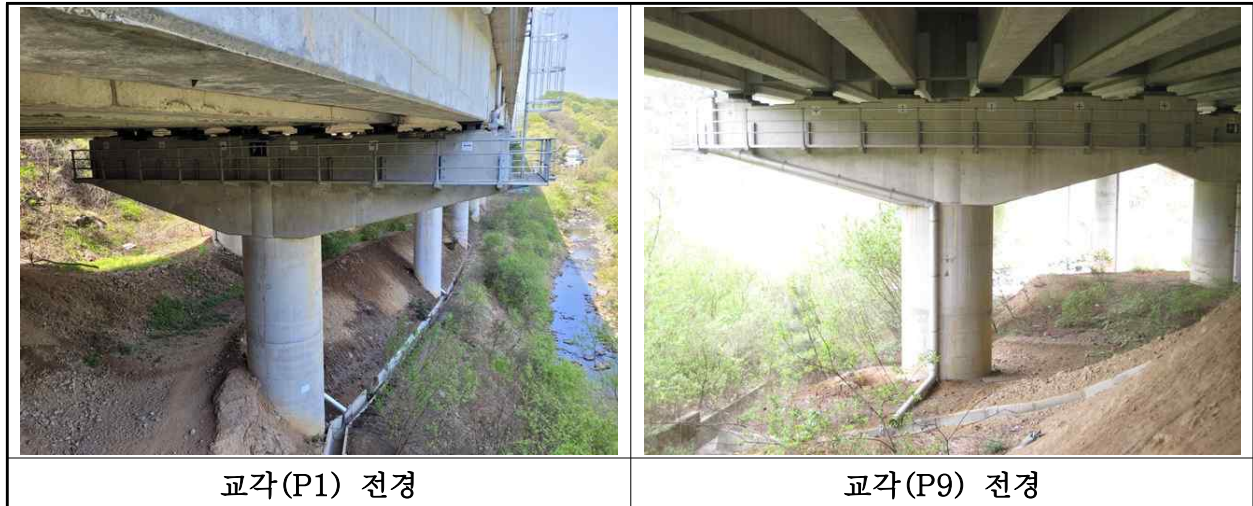
【사진 1.3.10】 교각 전경
