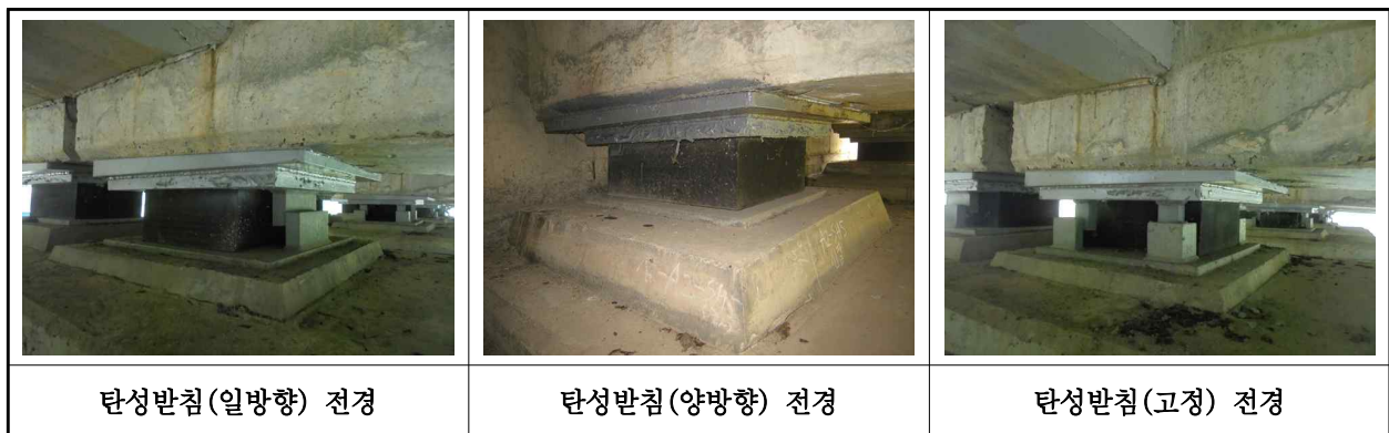
【사진 1.3.12】 교량받침 전경
