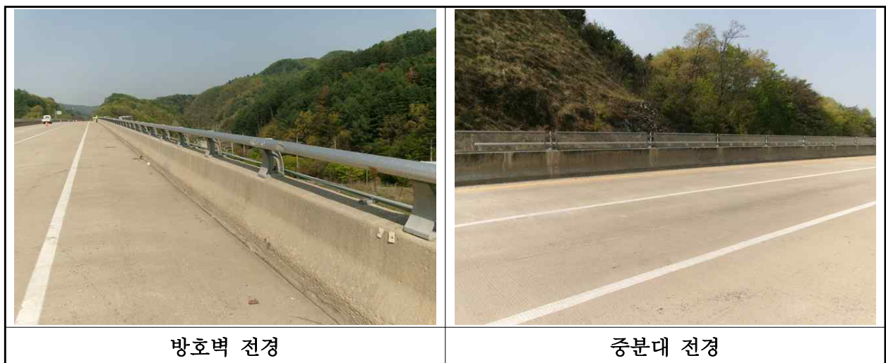
【사진 1.3.23】 방호벽 및 중앙분리대 전경
