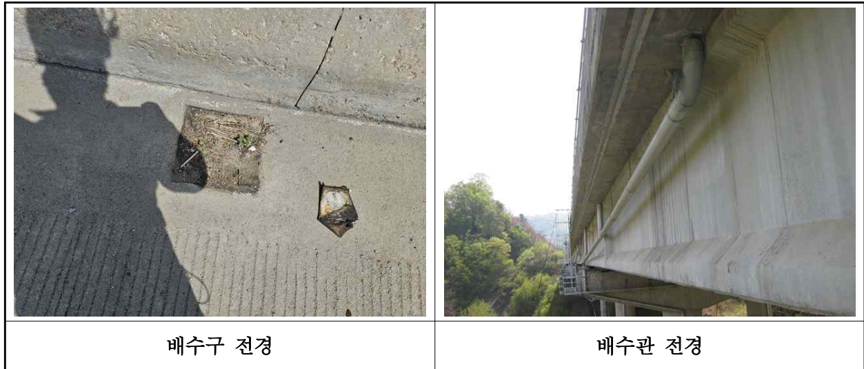
【사진 1.3.21】 배수시설 전경
