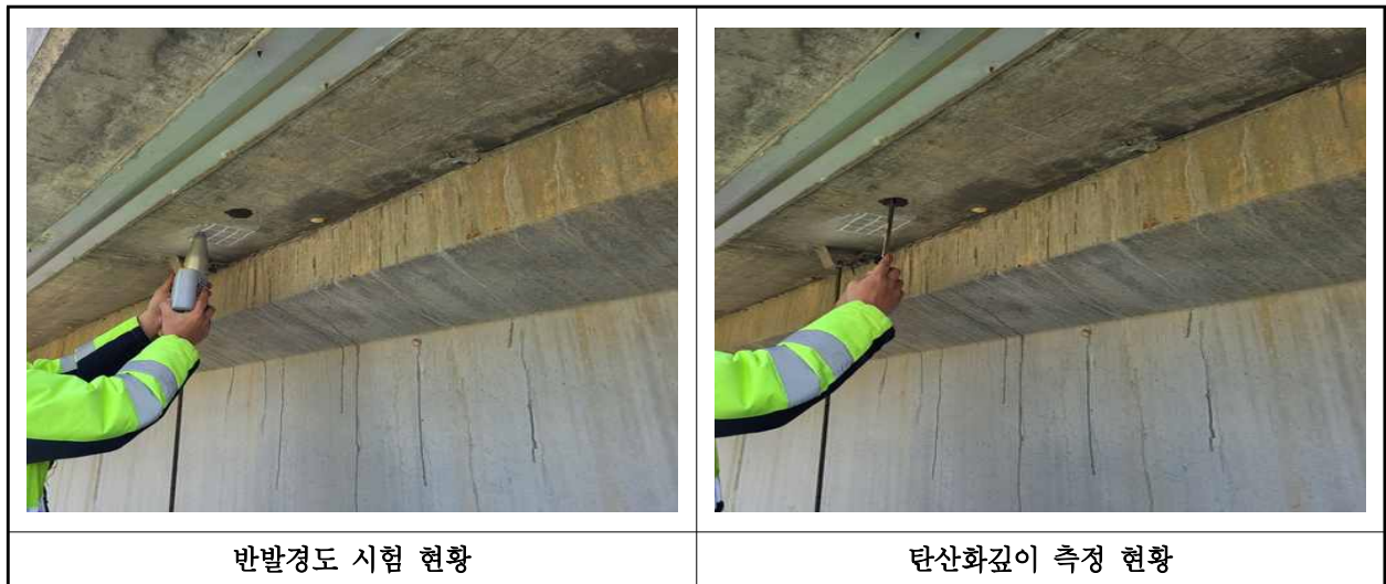
【사진 1.4.1】 콘크리트 내구성조사 현황
