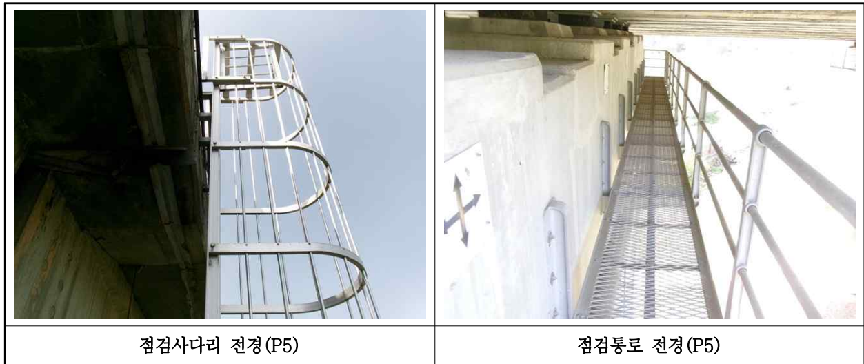
【사진 1.3.25】 교량 점검시설 전경
