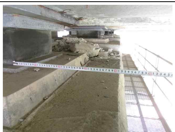
받침장치 연단거리 측정
