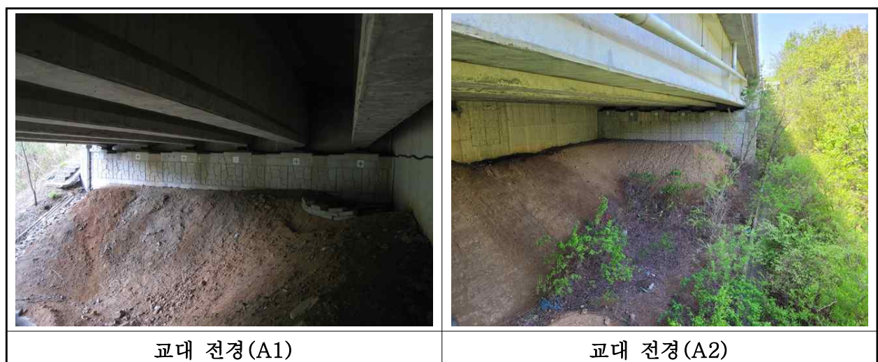
【사진 1.3.8】 교대 전경
